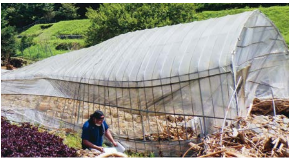
▲被災したハウスの被害調査を行っている様子
