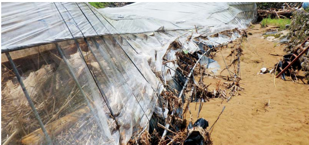
▲土砂流入により被害を受けたハウス
