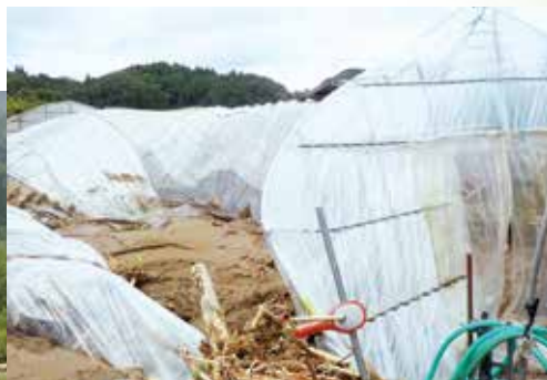
土砂に潰されたパイプハウス （日田市大肥町）
